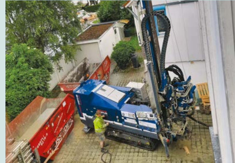
Für den Einsatz einer Erdwärmesonde wurde eine 95 m tiefe Bohrung veranlasst.
