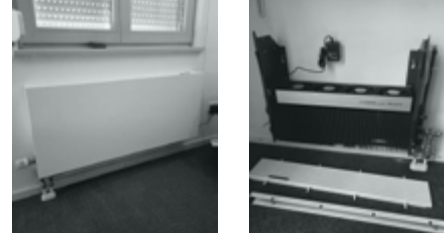
Niedertemperatur-Heizkörper (rechts geöffnet)
