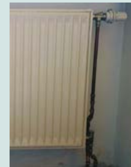
Zehn bestehende Heizkörper wurden beibehalten.
