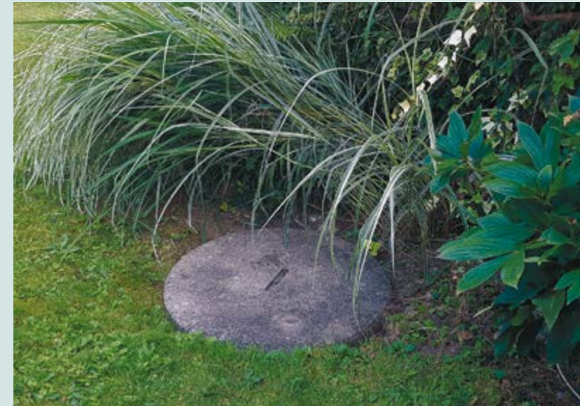
Im Garten wurden zwei Brunnen gebohrt. Sichtbar bleiben lediglich die Schachtdeckel.
