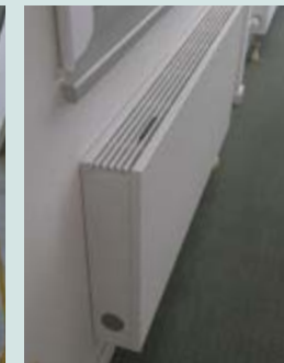
Im Dachgeschoss wurden vier bestehende Heizkörper durch Niedertemperatur-Heizkörper ersetzt.
