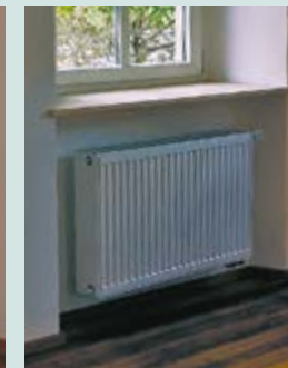
In drei Räumen wurde jeweils ein weiterer Heizkörper ergänzt.
