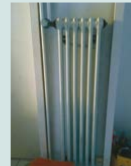
Fünf bestehende Heizkörper wurden beibehalten.
