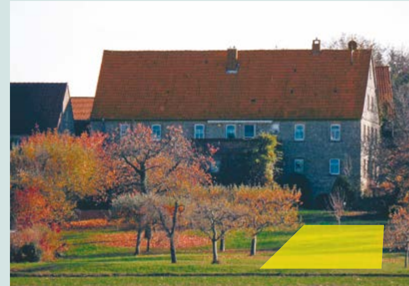
Im Garten wurde auf einer Fläche von 300 m 2 ein Erdwärmekollektor verlegt. (siehe markierte Fläche)
