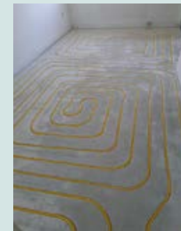
Im Erd- und Obergeschoss wurden Nuten für eine Fußbodenheizung in den bestehenden Estrich gefräst (ca. 100 m 2 ).
